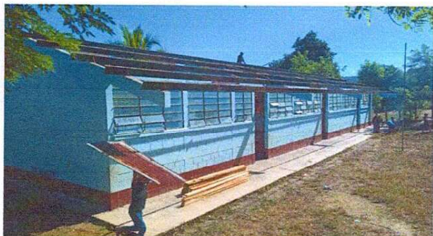
Foto 1: SE OBSERVA EL PROCESO DE CAMBIO DE LAMINAS. MODULO 1
