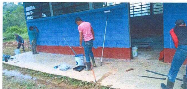
Foto 2: SE OBSERVA EL PROCESO DE PINTURA EN LA PARED. MODULO 1
