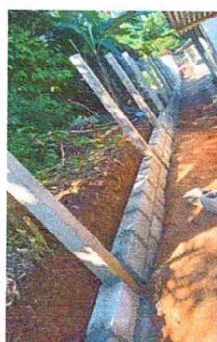
Foto 3: SE OBSERVA LA REMODELACION DEL MURO PERIMETRAL. MODULO 2
